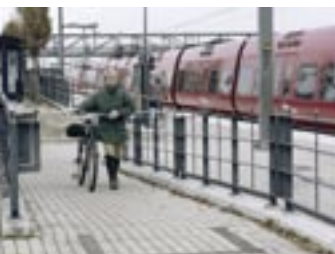
En rampe skaber lettere tilgængelighed. Her på Hundedige Station.
